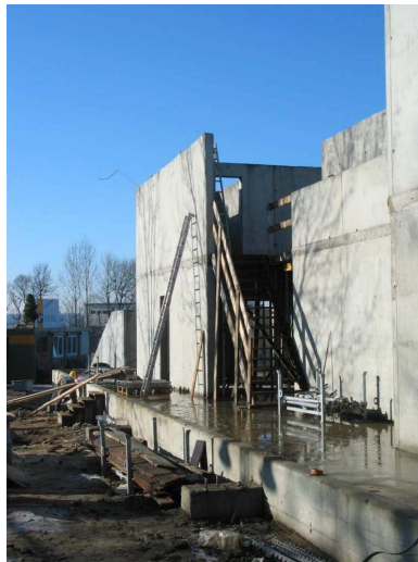
Eingangsbereich im Rohbau
