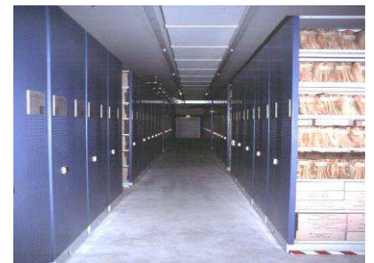
Fertiggestellter Magazinkeller mit Fahrregalen
