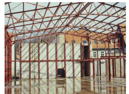
Rohbau nach Wiederaufbau der Reithalle mit alten Dachbindern (Spannweite 16,6 m)
