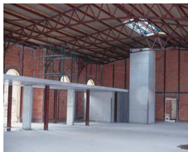
Rohbau Archivlesesaal: Galerie mit Stahlstützen und Stahlbetonverbunddecke
