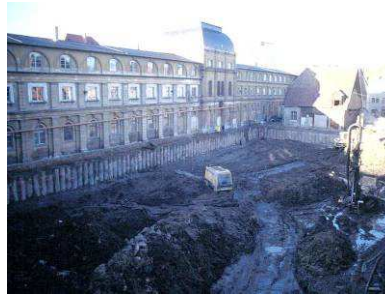
Baugrubenumschließung im Innenhof: Übersicht Bohrpfahlwand vor Bestandsgebäude
