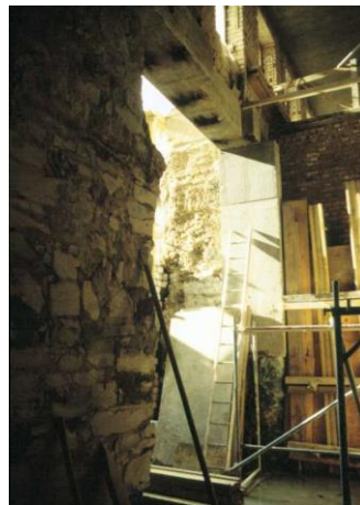
Fassadenabfangung im Bereich vom Westflügel
