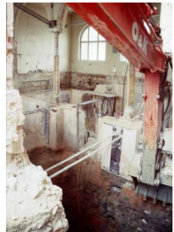
Herstellen des Kellers im Gebäudeinneren
