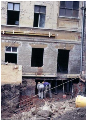
Fassadenabfangung für Anschluss Tiefenmagazin
