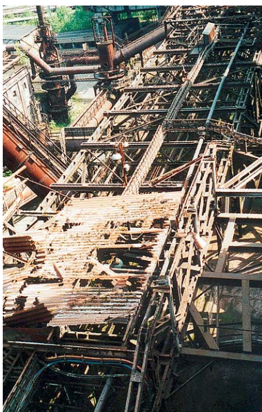
Blick auf die unsanierte Gichtbühne
