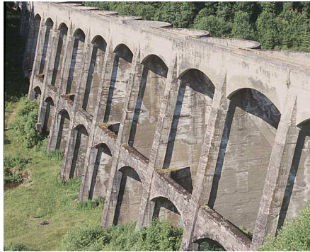
Staumauer vor der Sanierung
