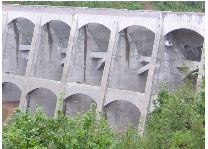
Blick auf die Staumauer nach der Betonsanierung
