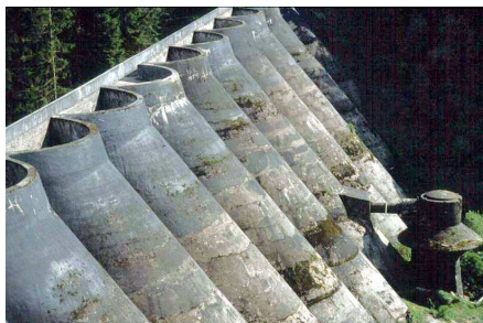
Aufsicht auf die Talsperrengewölbe vor Sanierung
