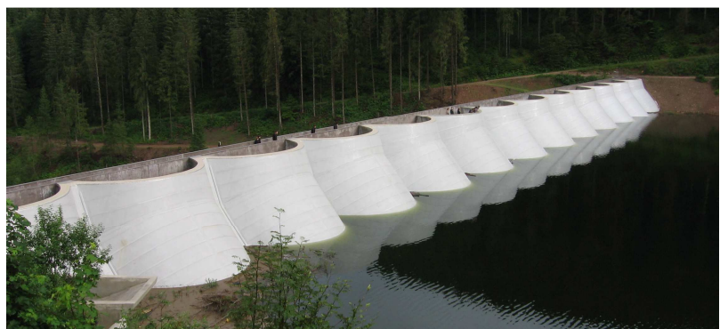
Die sanierte Staumauer wird 2007 wieder angestaut.
