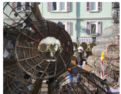
Bewehrungskörbe Tragpfähle Verbau
