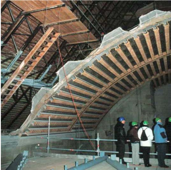
Rückbau der vorh. Gewölbeschale von 1957
