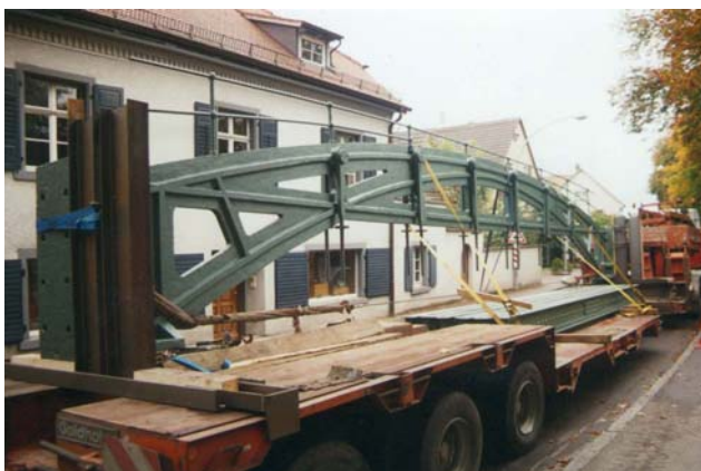
Antransport eines reparierten Brückenträgers
