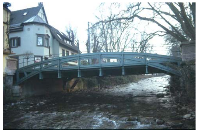
Die Brücke nach Abschluss der Sanierung
