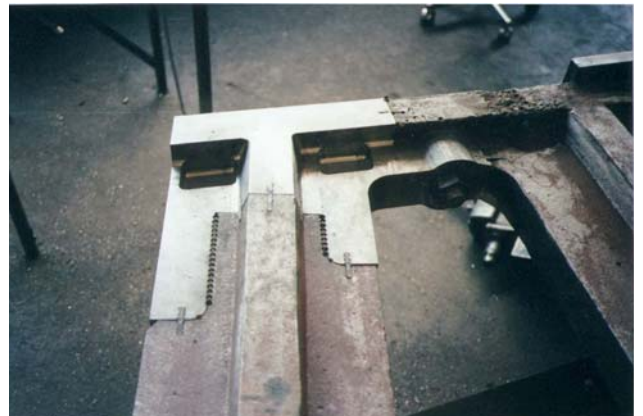
Reparatur durch Ergänzung im Metallock-Verfahren
