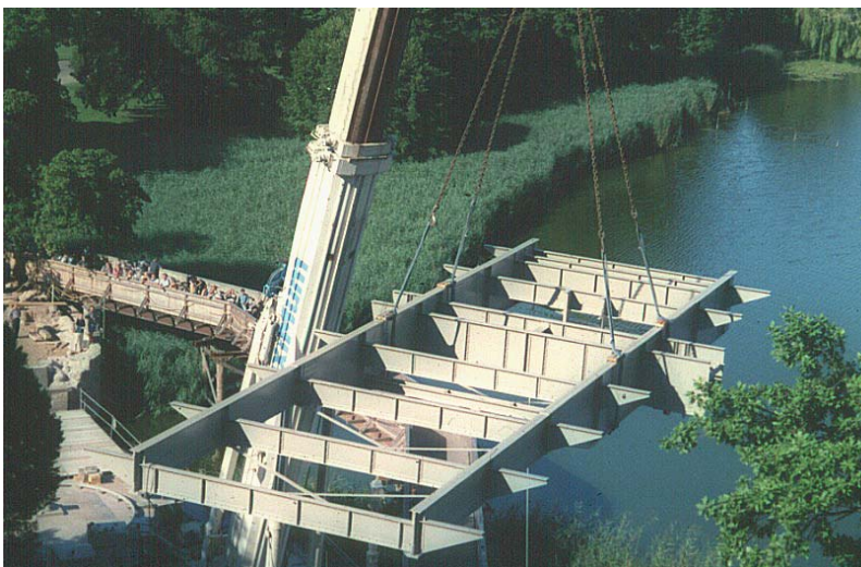
Einheben der sanierten Brücke
