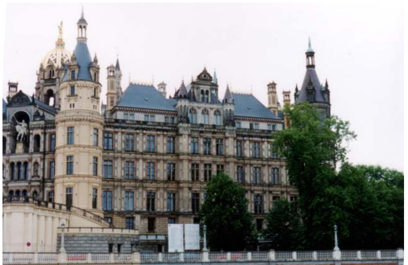
Fassade des Burgsee-Flügels zum Schweriner See vor der Mauerwerkssanierung
