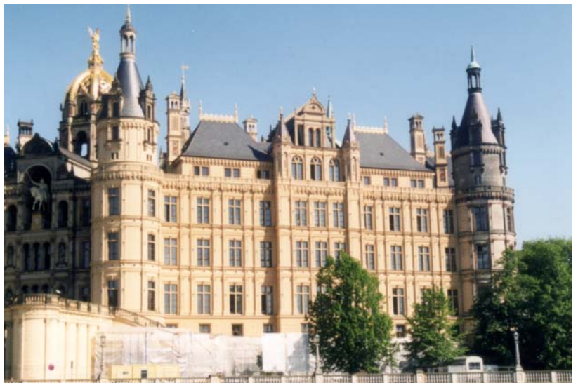
Saniert: Fassade des Burgsee-Flügels und Portalturm links im Bild
