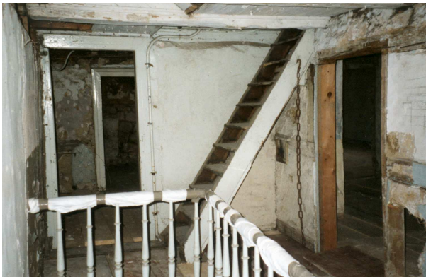
2. OG vor der Instandsetzung
