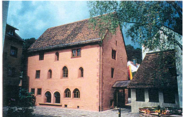
Südseite und Neubau Nebengebäude
