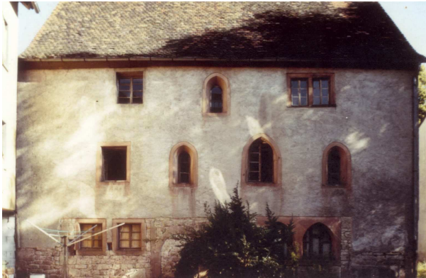
Südseite vor der Instandsetzung
