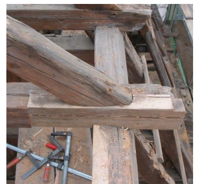
statische Unterstüztung bei der restauratorischen Stucksicherung im Kapellenbereich
