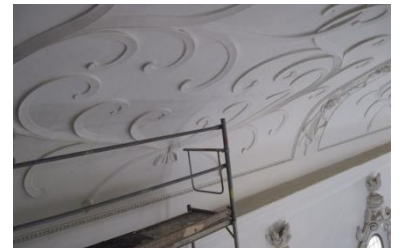
statische Unterstüztung bei der restauratorischen Stucksicherung im Kapellenbereich
