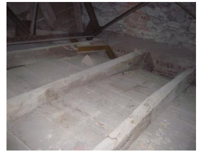
partielle Verstärkung der Tragkonstruktion der Decke über Kapelle
