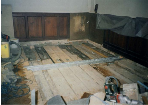
Instandsetzung Holzbalkendecke (Mann an Mann Decke) von oben mit liegendem Blattstoß unter Erhalt der historischen Stuckdecke über Kurfürstenzimmer
