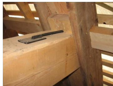
überlegte Verwendung von Stahlverbindern für zugfeste Anbindung
