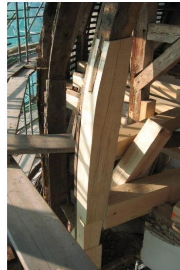
Einsatz zimmermannsmäßiger Holzverbindungen bei Reparatur Sparrenfuß
