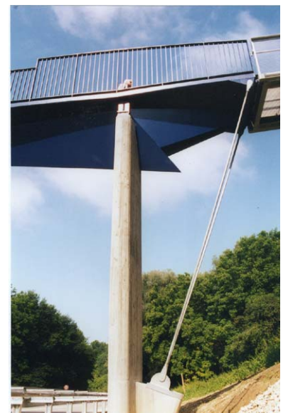
Anschluss Träger - Stütze
