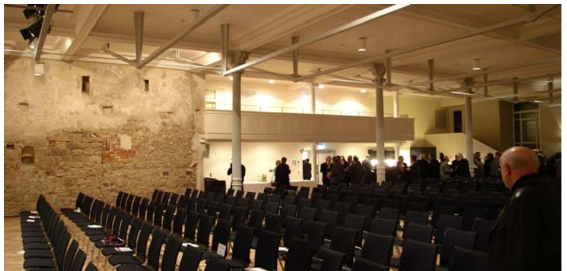
Sichtbarer Unterfurt der Tragkonstruktion über dem Sonnensaal
