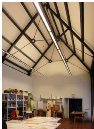
Polonceauträger Bereich Kunstschule
