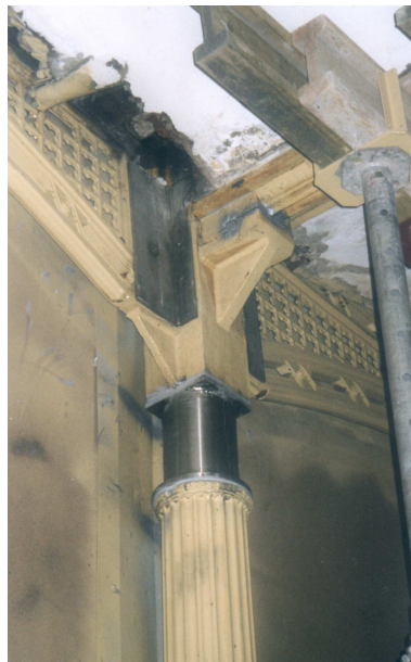
Säulenteil wurde in situ ersetzt, Bogenträgeranschluss ausgesteift
