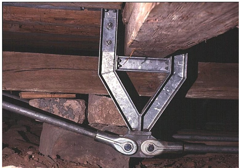
Stahlkonstruktion zum Abfangen abgesunkener Balkenlagen (s. links)
