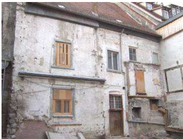
Marktstr.45: Hofwandsicherung mit außenliegendem Stahlträger
