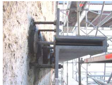
Marktstr.45: Hofwandsicherung mit außenliegendem Stahlträger
