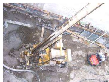
Düsenstrahlarbeiten im Hof
