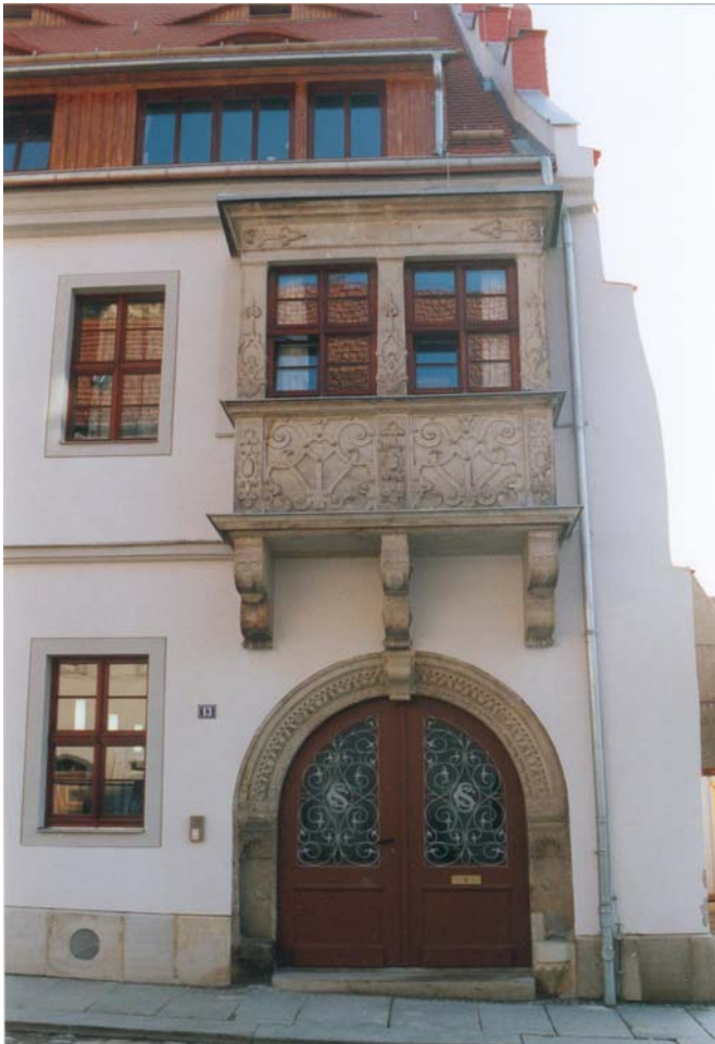
Nordansicht des Haupteingangs nach der Instandsetzung
