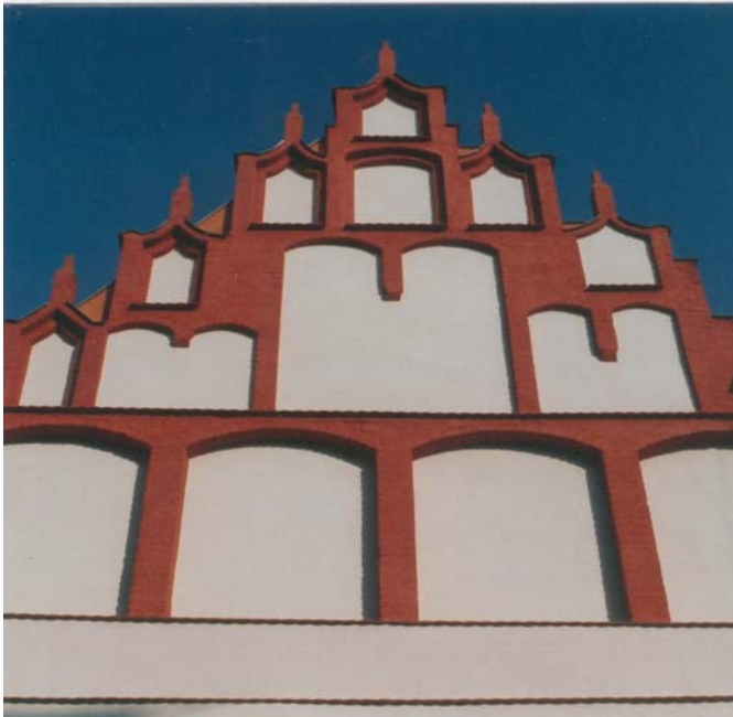
Gotischer Westgiebel nach der Instandsetzung
