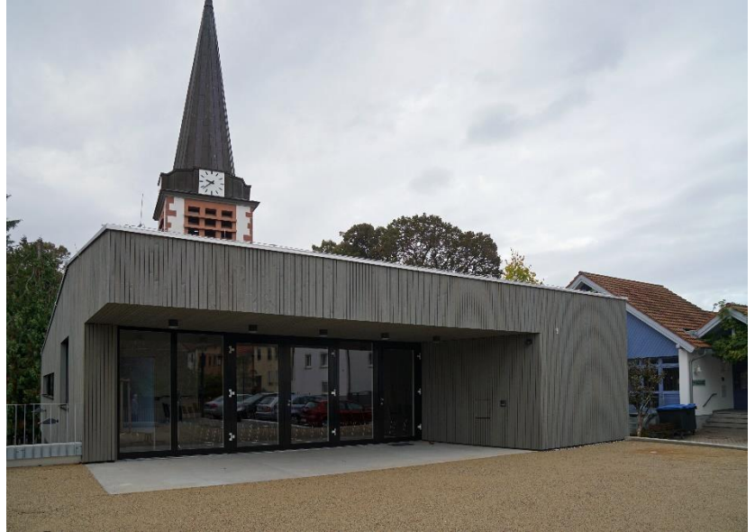
Blick auf die Terrasse, Ebene Hanggeschoss
