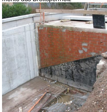
Stützmauern für Außenanlagen mit neuem Geländeverlauf
