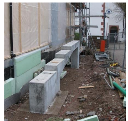
Unterkonstruktion für Treppe Zugang Erdgeschoss
