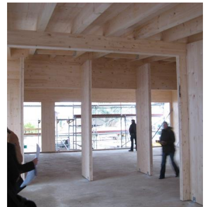
Wand- und pfeilerartige Stützelemente aus Brettsperreholz
