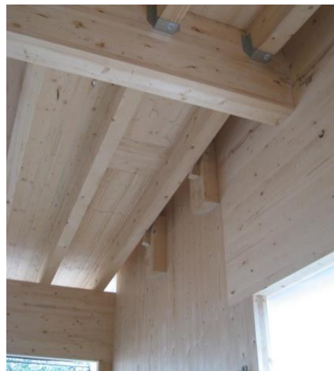
Dachkonstruktion aus Brettschicht- und Konstruktionsvollholz, sowie Wandelemente aus Brettsperreholz
