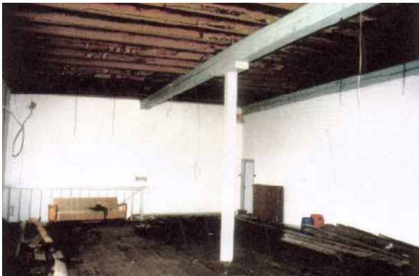
1. OG vor der Instandsetzung
