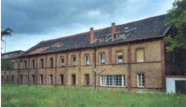
Westseite vor der Instandsetzung
