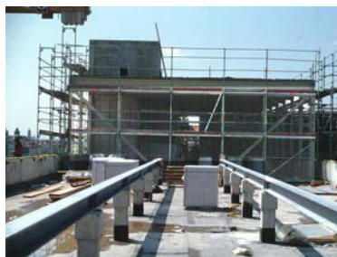
Stahlträger für Lüftungszentralen auf Dachgeschossdecke, im Hintergrund Penthouse mit Aufzugsschacht
