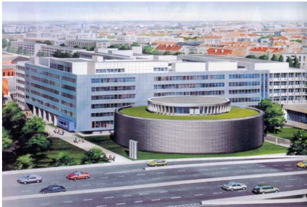
Atriumgebäude + Betriebszentrale (runder Baukörper)
