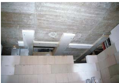
CFK-Lamellen mit Brandschutzverkleidung umschließen Deckendurchbruch
