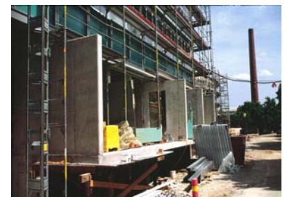
Auskragende Bürozellen im EG: neue eingestellte Wandscheiben tragen Fußboden
