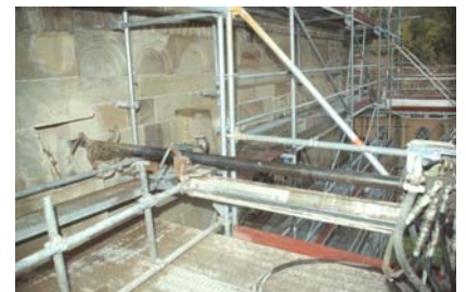
Bohrlafette zur Herstellung einer zielgerichteten Kernbohrung in der südlichen Längswand
