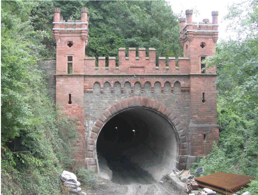
Ansicht Nordportal Alter Loreleytunnel
