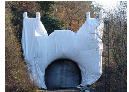
Tunnelportal während Instandsetzungsarbeiten
