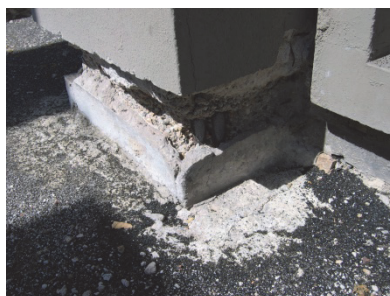
Instandsetzung Rahmenstütze
