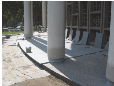
Verlegen neuer Belag Umgang
