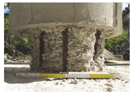
Stützenfuß äußerer Ring Umgang
