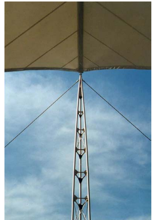
Anschluss Membran - Pylon - Abspannung
