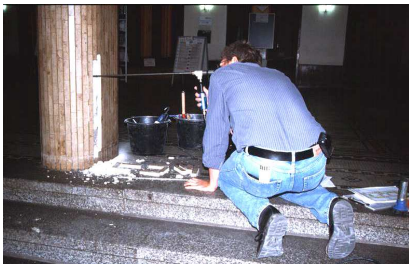
Endoskopie zur Stützenerkundung
