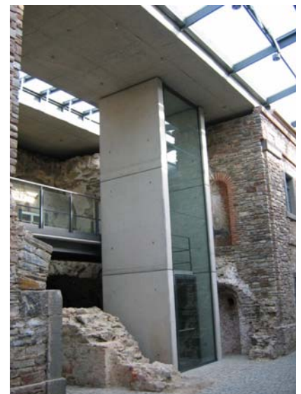
Großer Bombentreffer im Innenhof Lange Linie
