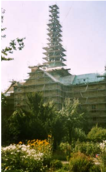
Ostansicht des eingerüsteter Chor und Dachreiter
