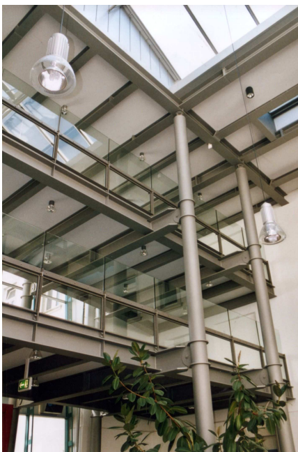
Verbindungsebenen im Foyer
