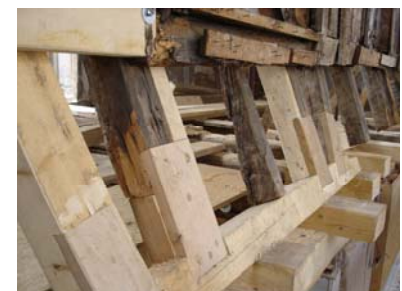
Reparatur Mansarddach WG
