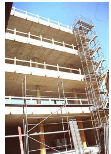
Südseite des Bürotrakts mit Flachdecken und Brüstungsträgern
