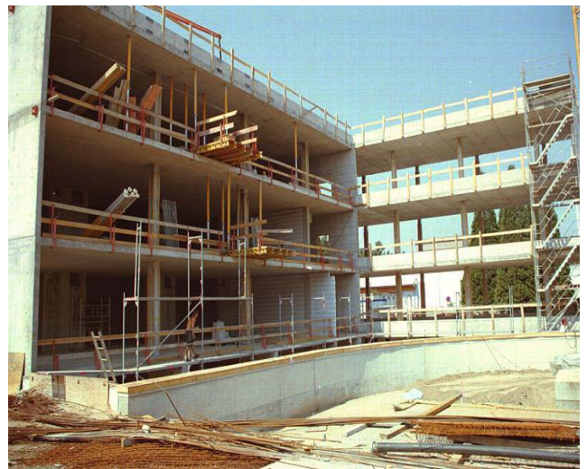
Südwestseite: Stützmauer vor Lichthof (noch nicht verfüllt)
