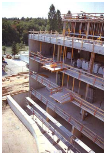
Westseite: Laborbereiche mit Technikzentrale (Dach) und Lichthof
