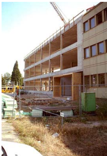
Nordansicht: Bürotrakt mit Anschluss an den Bestand (rechts)
