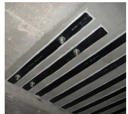
Bestandsdecke, ertüchtigt durch CFK-Lamellen
