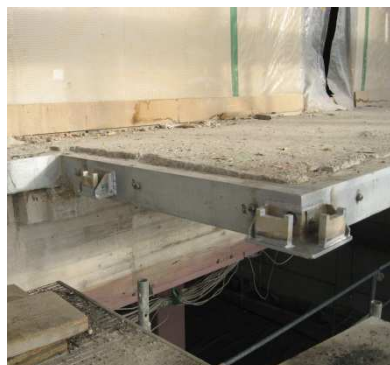
Zurückgeschnittener und für neue Fassadenlasten mit entsprechendem Anschluss ertüchtigter Deckenrand
