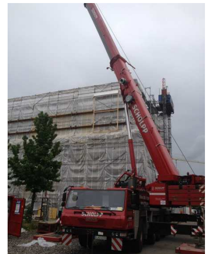
Einheben neuer Fassadenteile mit schwerem Autokran, der sich zu Teilen auf die Tiefgarage ablastet
