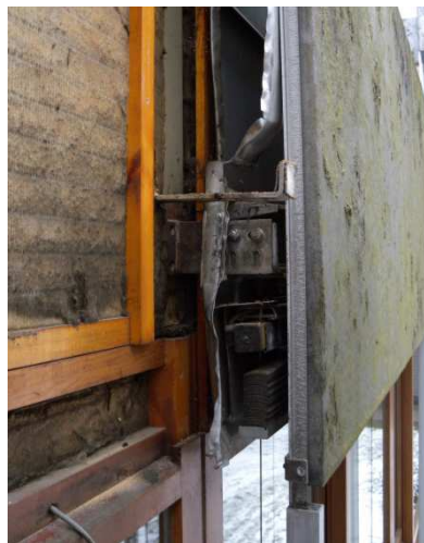
Bestandsfassade im Bereich der Aluminiumgussplatten
