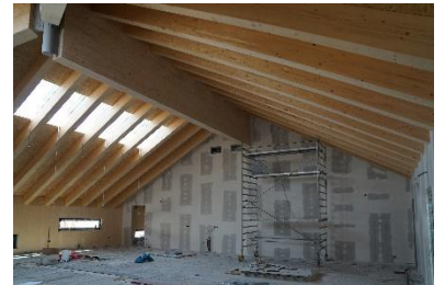
Blick in Krafraum Dachgeschoss
