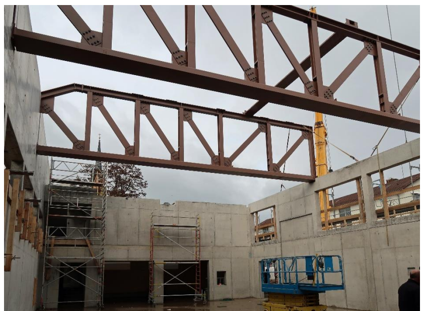
Montage raumhohe Stahlfachwerkträger
