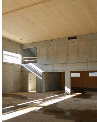
Blick aus Turnhalle Richtung Geräteraum
