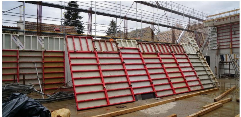
Bauzustand Bereich Turnhalle
