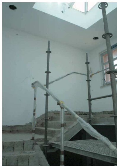
Treppenhaus in der Bauphase
