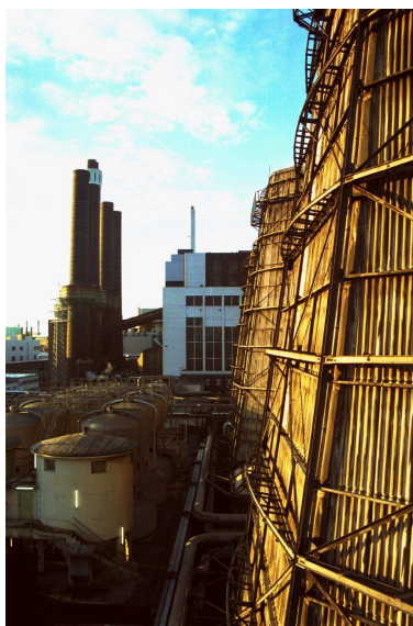
Die horizontalen Traversen zwischen den Eckstielen sorgen für die Aussteifung der Seitenflächen
