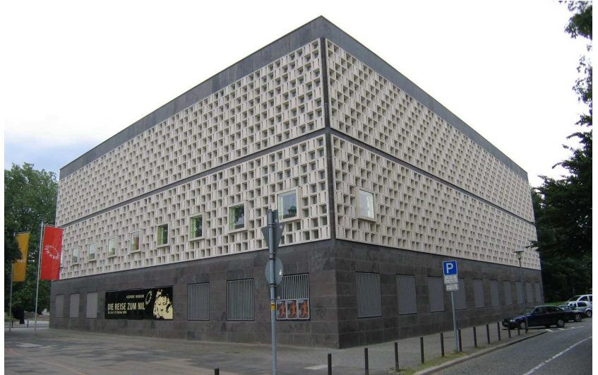
Nord- und Westfassade
