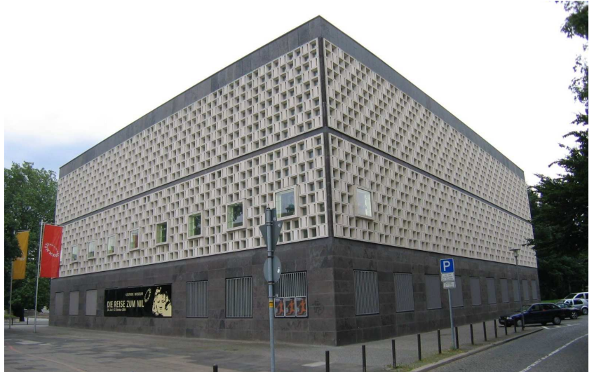
Nord- und Westfassade
