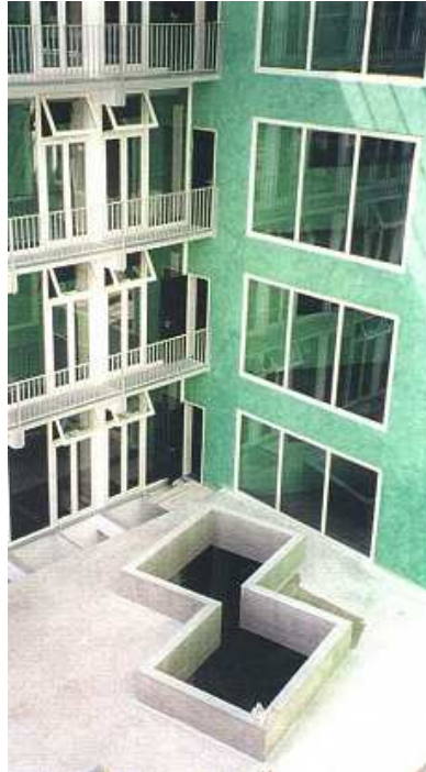
Draufsicht Deckenöffnung in Lichthof © AGP
