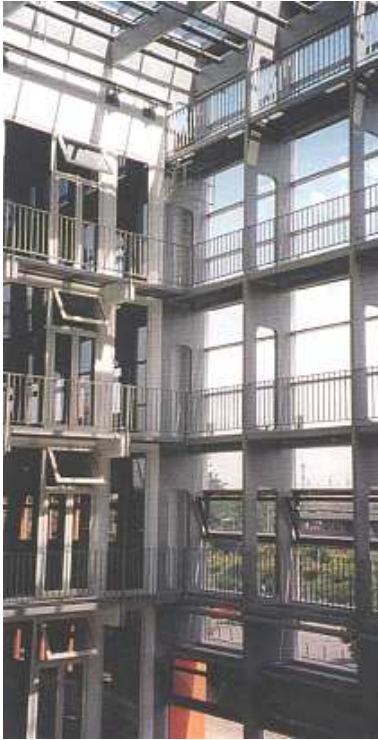
Innenansicht Fassadenstützen mit Stegen © AGP
