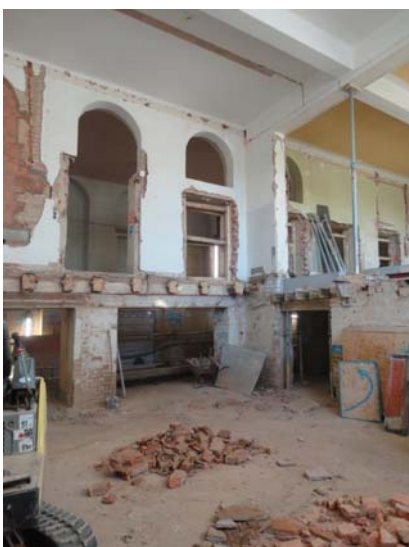
Ersatz Holzbalkendecke über UG
