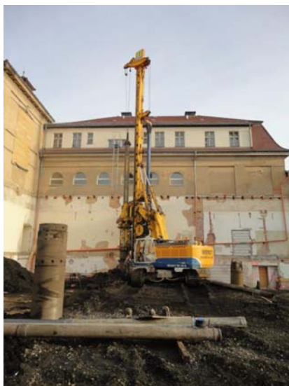
Gebäudegründung mit Bohrpfehlen
