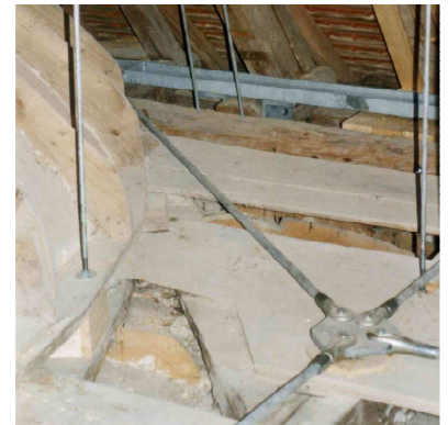
Zugstangenverstreben leiten die Horizontalkräfte am Kuppelrand schadensfrei ab.
