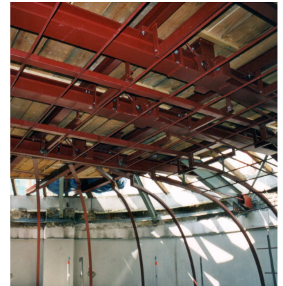
Die horizontalen Abspannungen des Notdaches sind entfernt, die Tragkonstruktion für die gewölbte Stuckdecke ist eingebaut
