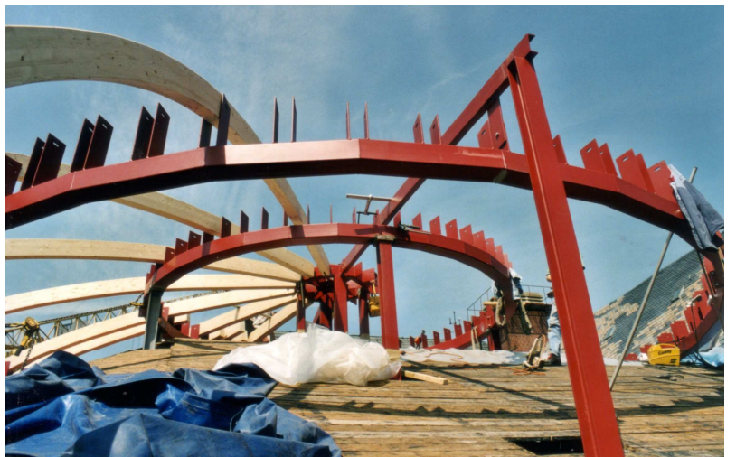
Alte Stahlträger mit den Verstärkungen für die Auflagerung der neuen Außenkuppel und zur Anhängung der raumabschließenden Stuckdecke des Hörsaals
