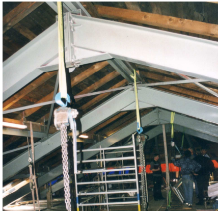
Stahlträger mit aufgelagertem Notdach
