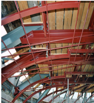
Alte Stahlträger mit den Verstärkungen für die Auflagerung der neuen Außenkuppel und zur Anhängung der raumabschließenden Stuckdecke des Hörsaals
