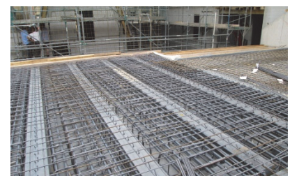
Decke über 2. OG, HBV-Decke
