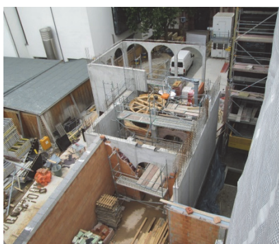
Blick aus Südwest, entstehendes EG
