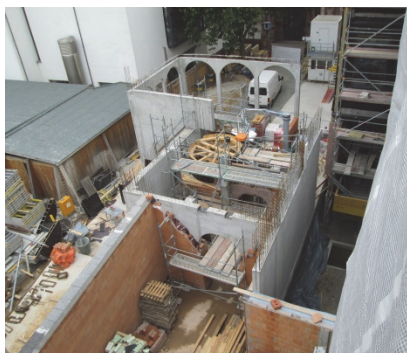
Blick aus Südwest, entstehendes EG
