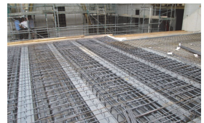
Decke über 2. OG, HBV-Decke
