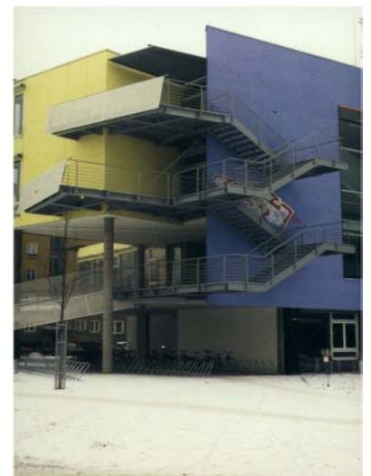
Fluchttreppe im Süden
