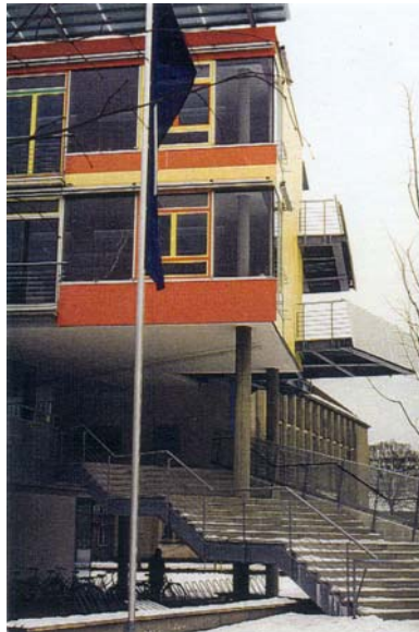
Freitreppe auf der Südseite
