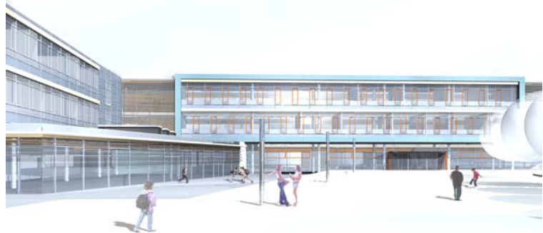
Ansicht Schulgebäude mit Mensa
