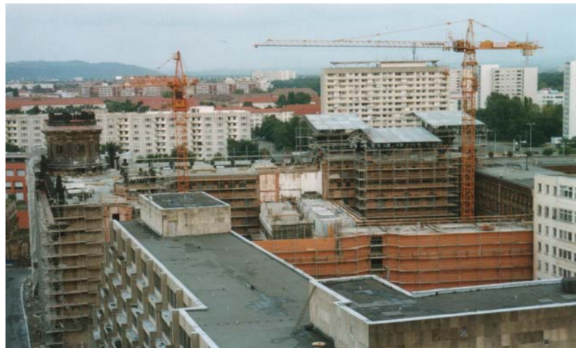
Blick auf neue Flügel (⊥ in Bildmitte) und eingerüsteten Altbau (im Hintergrund)
