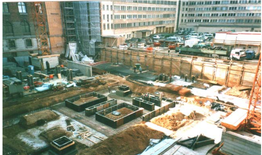
Blick in die Baugrube
