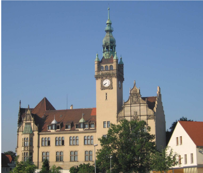
Blick auf die Ostfassade
