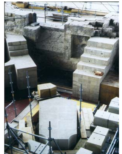
Neue Innenpfeiler im Bestand
