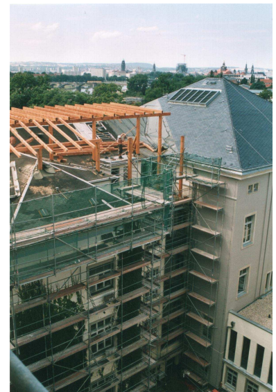
Schutzdach über B-Flügel während Verlegung der Geschossdecke
