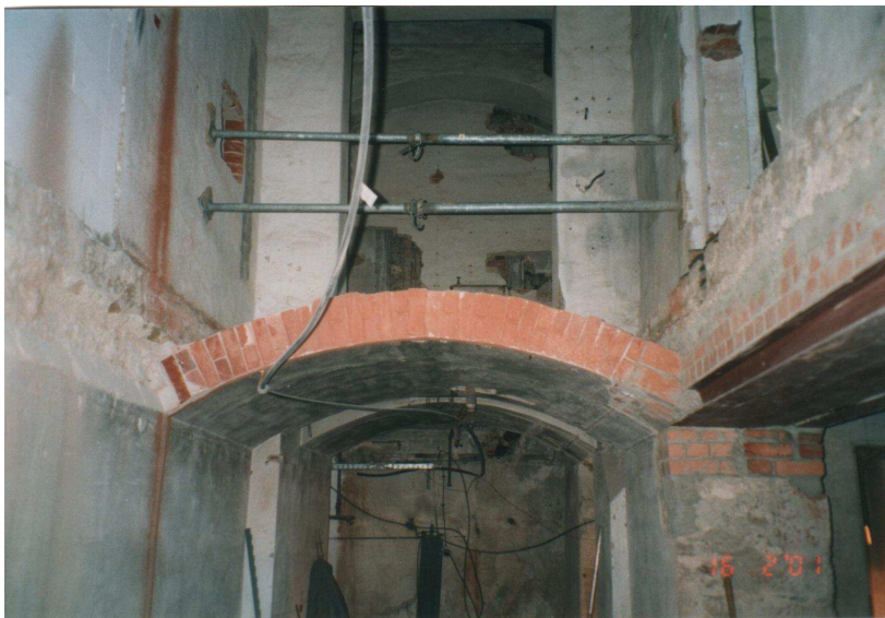
Geänderte Raumaufteilung: Einbau neuer Unterzüge unter ausgeschnittenem Tonnengewölbe
